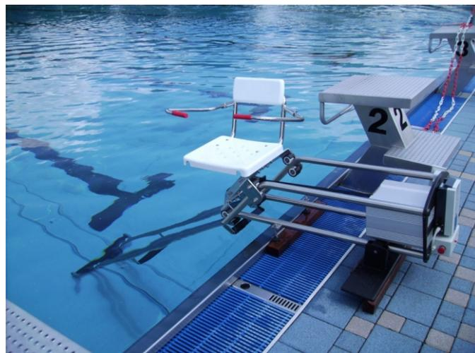
Die Basisanlage ist für Becken mit 135 bis 150 cm Wassertiefe ausgelegt. Bei anderen Wassertiefen wird der Fahrbahneinschub bis zur vorhandenen Wassertiefe herausgezogen und arretiert.
